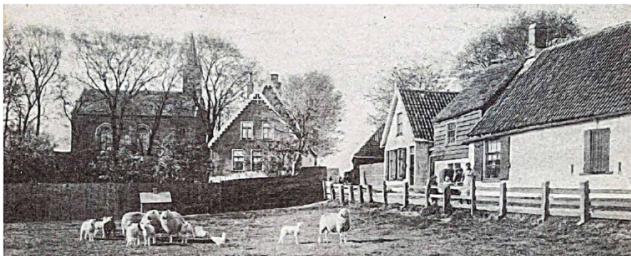
Afb. 6. De neoromaanse kerk uit 1860 gezien vanuit het zuiden.
