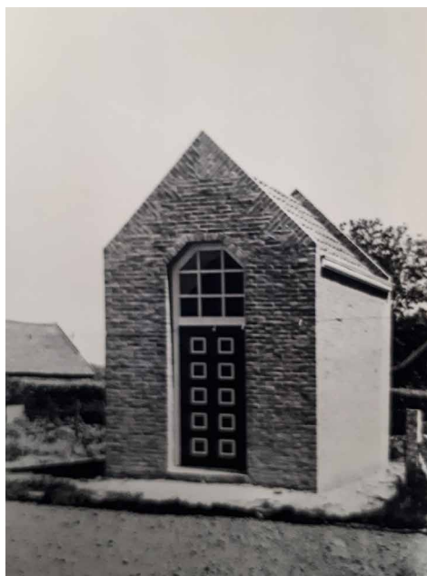
Afb. 38. Het lijkbearhuisje kort na de oplevering. Het Nieuwe Instituut, Rotterdam.
