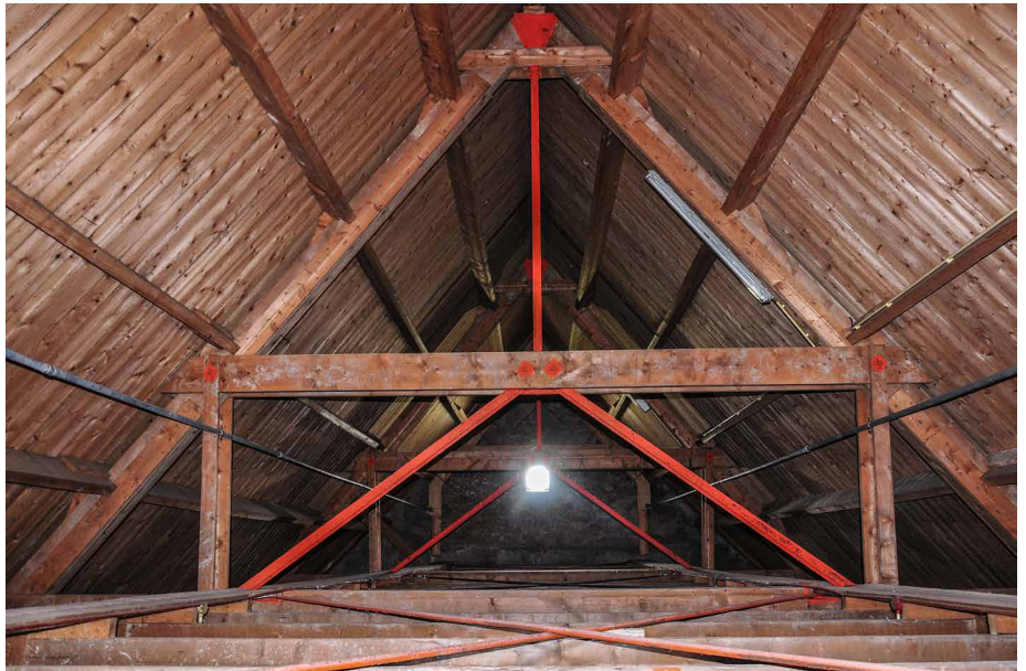
Afb. 35. De kapconstructie. Foto auteur.
